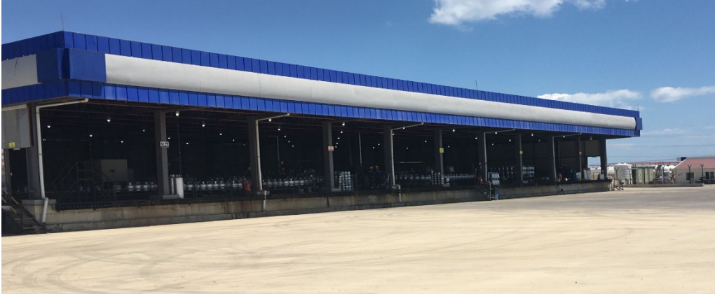
Tüp Dolum Rampası
